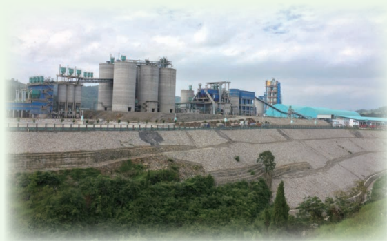
金沙公司进厂大道侧边坡
